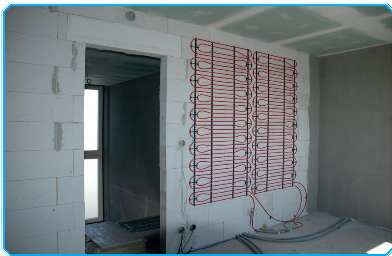
Obrázok 26: Nízkoteplotné vykurovanie/chladienie v pasívnom dome (Hviezdoslavov) pred omietnutím
