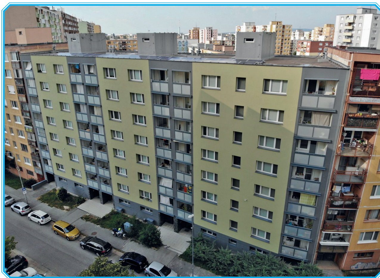
Obrázok 17: Zvýšenie tepelnej ochrany obvodového pláštia na bytovej stavbe (ulica P. Horova, Bratislava)
