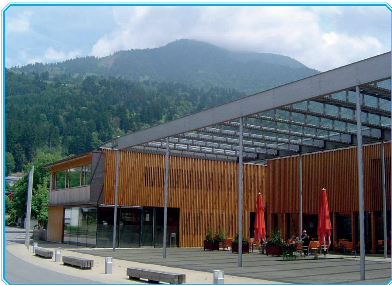
Obrázok 16: Komunitné centrum Ludesch (Rakúsko) v pasívnom energetickom štandarde a s fasádou z dreva získaného z okolitých lesov
