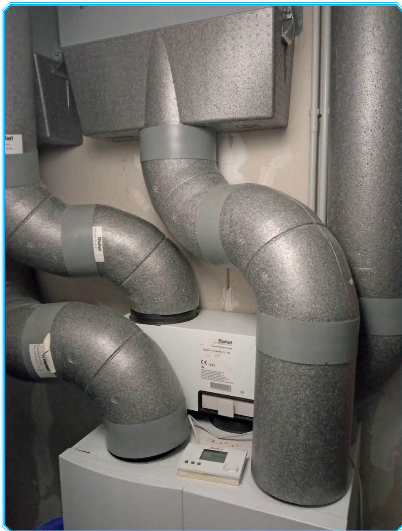
Obrázok 20: Osadenie radiaceho modulu riadenia vetrania s rekuperáciou tepla a bypassom
