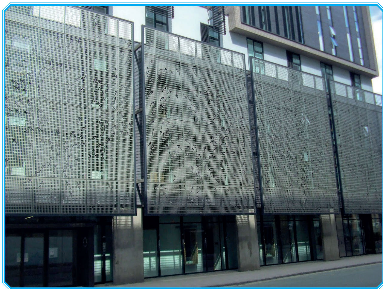
Obrázok 18: Tienenie transparentných otvorov pevnou konštrukciou v Manchestri
